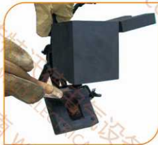
Step8.清理模具,进行下一个焊点操作
