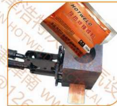
Step5.将焊粉放入模具中,放入引火粉覆盖在焊粉上,并在模具口处留少许
