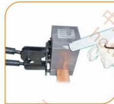
Step6.使用点火枪点燃引火粉,人必须站在模具口侧面
