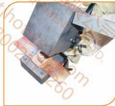
Step7.20秒后,开启模具,清理焊点表面残渣
