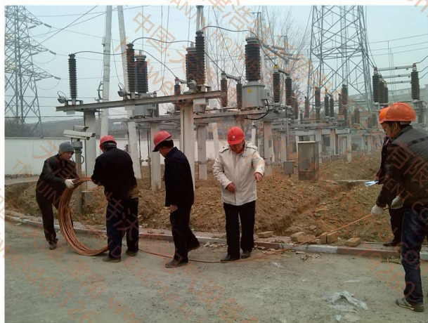
敷设铜覆钢接地绞线时避免拖动，防止铜层划伤。 HOTWELD七股铜覆钢接地绞线可直接切割，无需捆扎。
