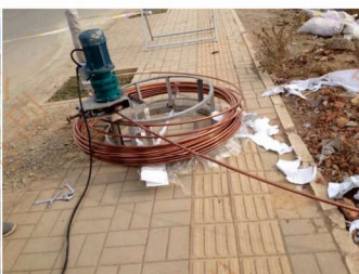
直径超过14mm铜覆钢接地圆线需要使用专用的调直机调直使用
