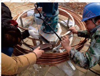
直径超过14mm铜覆钢接地圆线需要使用专用的调直机调直使用
