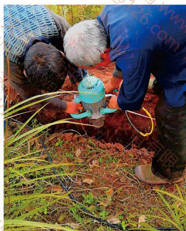
使用电动工具安装铜覆钢接地棒
