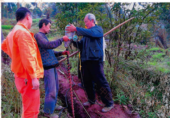
地质坚硬，预开孔方式安装铜覆钢接地棒
